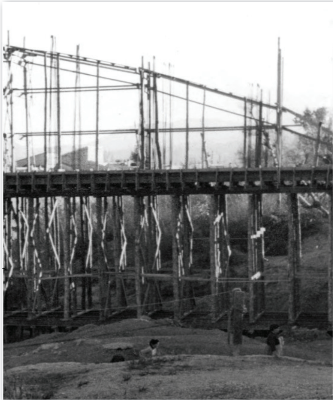
Construcción del puente de Beniel. Rubio Galvez, Jose. 2008. El río, puente y riadas. En: Recuerdos de un pueblo. (págs. 46-79)
